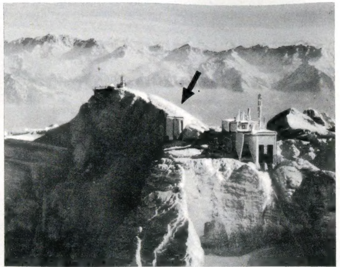
Blick auf den Sântisgipfel mit Endstation der Drahtseilbahn und der durch eine Kunststoffwand abgedeckten UKW- und Fernsehsenderantenne (s. Pfeil)
